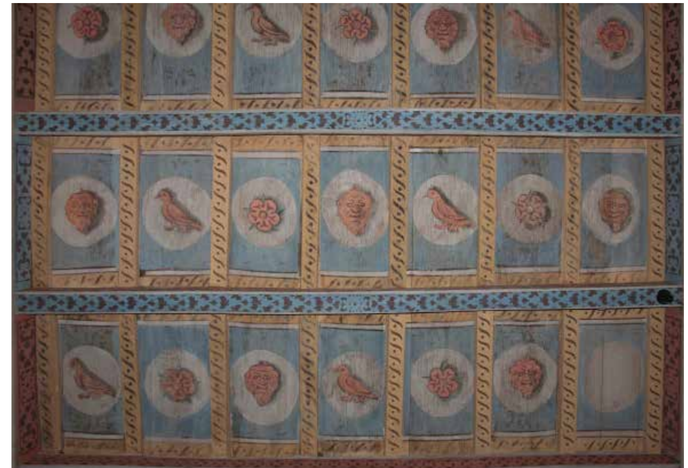
17. Soffitto della sala Savelli, 1605-1607 circa. Ariccia, palazzo Chigi, mezzanino destro
